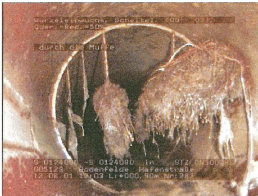
Ansicht 26: Beispielhafte Abbildung eines Wurzeleinwuchses in einen Kanal<sup>59</sup>
