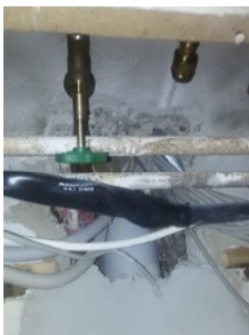
Ansicht 17: Wasserführende Druckleitung in einem Serverraum
