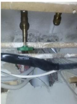
Ansicht 17: Wasserführende Druckleitung in einem Serverraum
