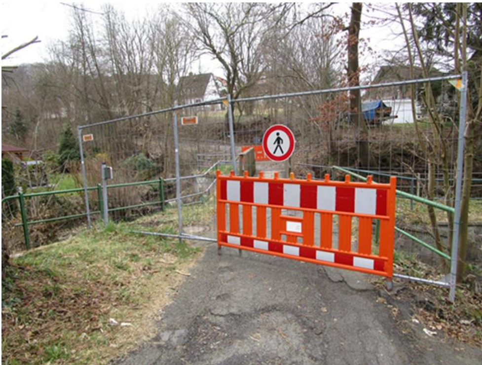
Ansicht 13: Gesperrte Brücke 75
