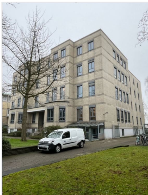
Abbildung 36: NDR-Gebäude Rothenbaumchaussee/Werderstraße (Quelle: LRH)
