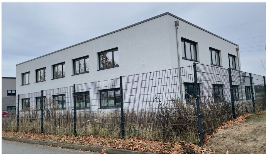
Abbildung 23: Außenstelle Lüneburg des Finanzamts für Großbetriebsprüfung Stade – nur Erdgeschoss – (Quelle: LRH)
