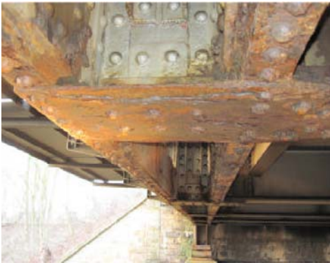
L 390 – Brückenbauwerk in Seelze
