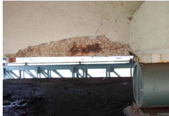
L 434 – Weserbrücke in Fuhlen
